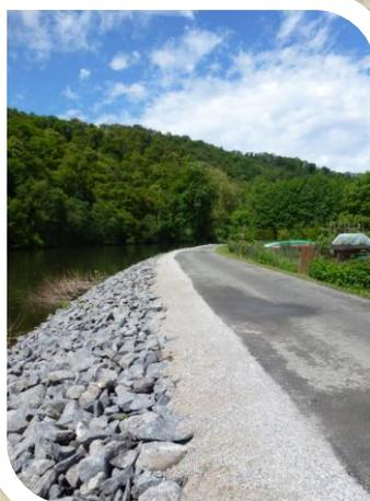
Der Lahnuferweg am „Kappesport“ zeigte an verschiedenen Stellen Risse auf und das Ufer brach teilweise ab. Nachdem das Wasserschiffahrtssamt informiert wurde, sind alle Schäden, inklusive des stark wuchernden Springkrautes beseitigt worden. Ein dicke Folie wurde eingebaut und das Ufer mit neuen Steinen befestigt.
